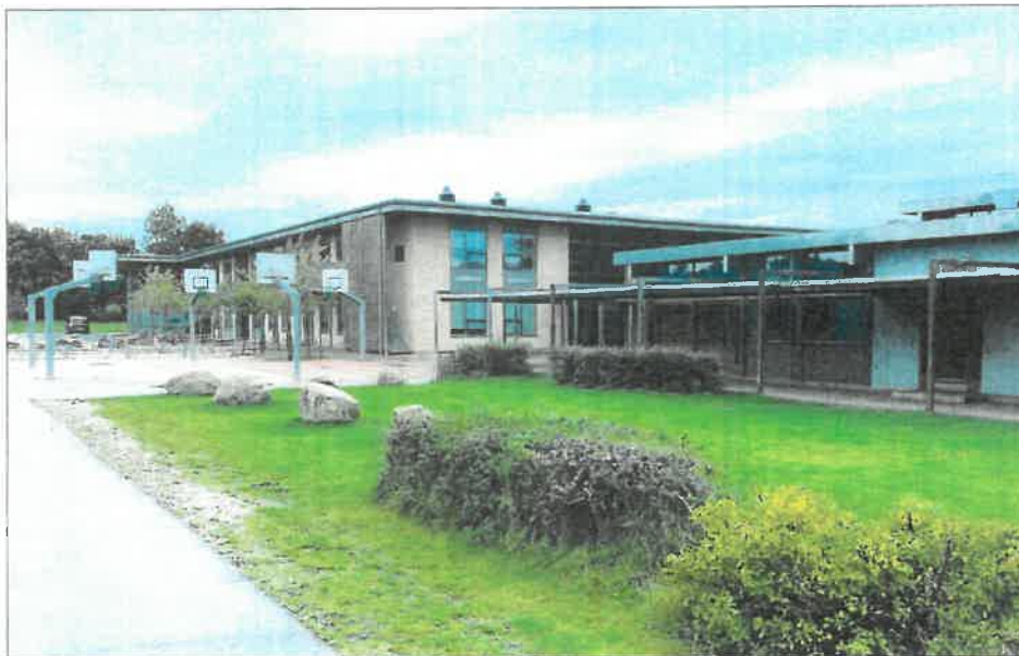
Bjergmarksskolen skal renoveres og det vil koste 118 millioner kroner. En udgift, der skal afholdes uanset, om man vælger at udbygge eksisterende skoler eller at bygge en ny. Foto: Kaj Ove Jensen
